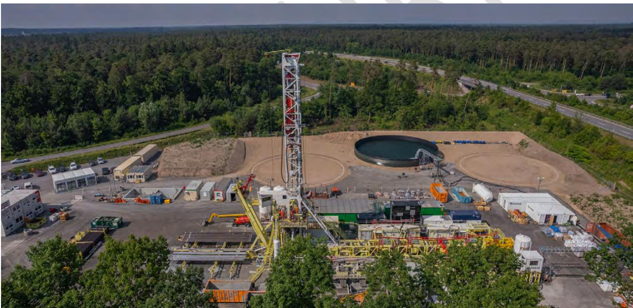
Abbildung 24: Drohnenaufnahme des Bohrplatzes in Graben-Neudorf (Deutsche ErdWärme GmbH, 2022)
